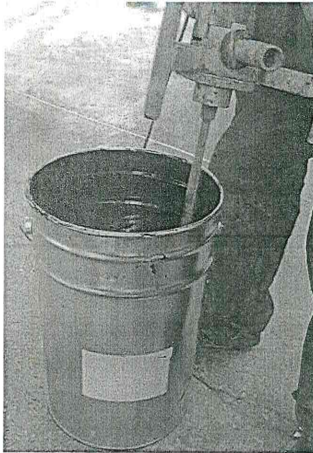
Рисунок 4 – Приготовление композиции грунтовочной трехкомпонентной КГр-3 «БАЗИС-2002»
