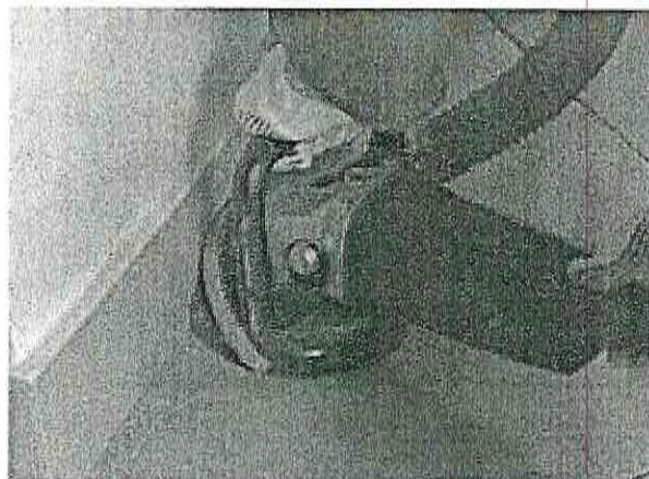
б) шлифование пола ручной шлифовальной машиной
